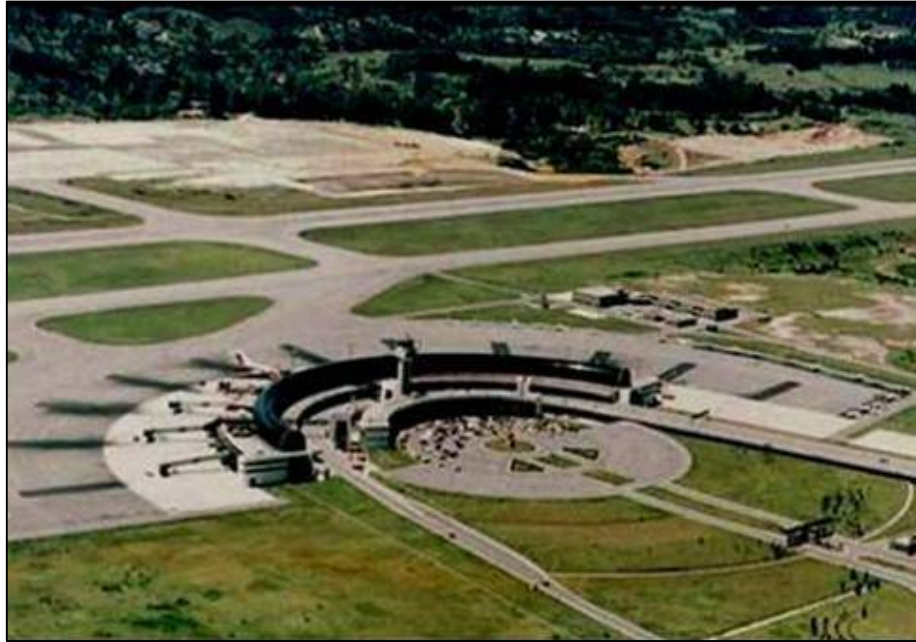
Foto N° 10 - Aeropuerto José María. Córdoba
