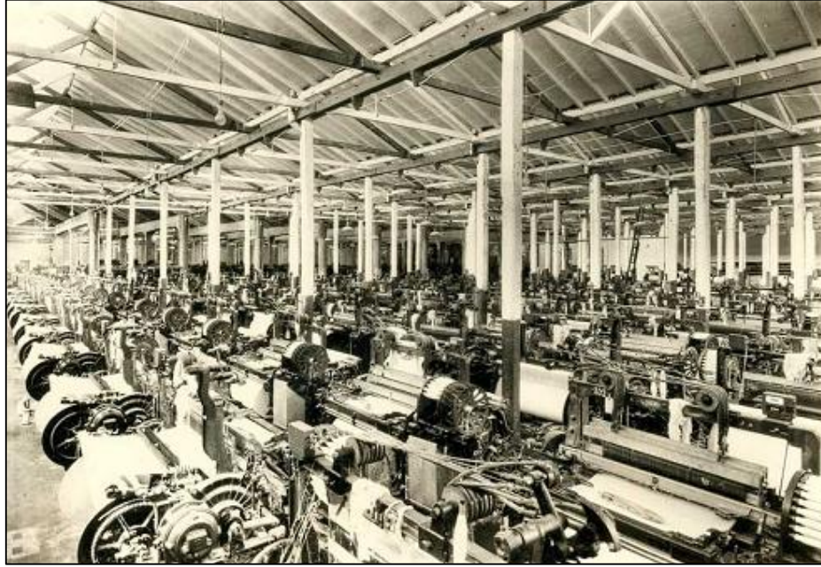
Foto N° 7 - Fabricato, salón de una planta de textiles, 1938
