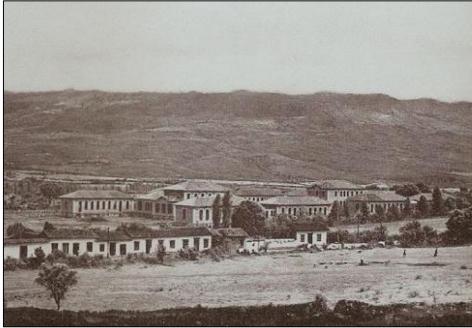
Foto N° 25 - Hospital San Vicente de Paul
