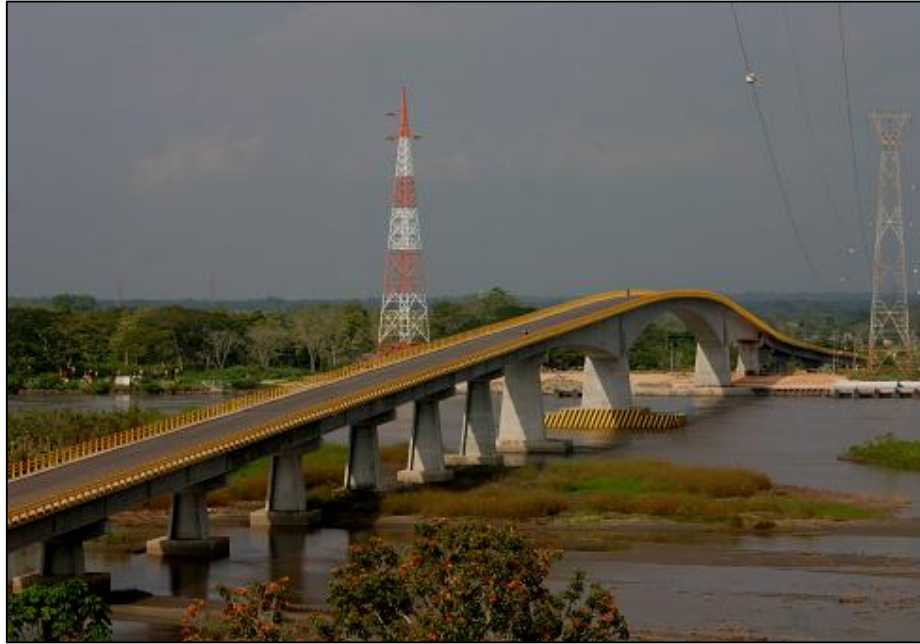
Foto N° 31 - Puente sobre el Magdalena
